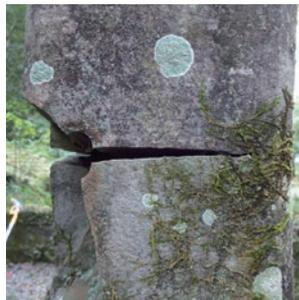
写真8 東側門柱の孔と亀裂
