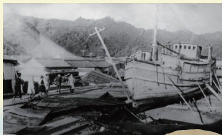
津波被害に遭った宇佐町「昭和南海地震被災写真」（高知県提供）
